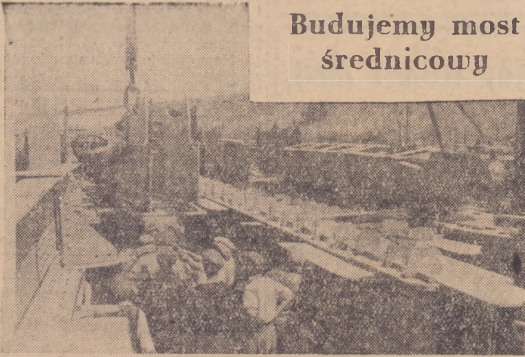
Most kolejowy linii średnicowej powoli zjeżdża do Warszawy ze śląskich hut. Potężne dzwigi zdejmują z wagonów ciężkie części konstrukcyjne i składają je na przyczółku mostowym. A wykonane już filary czekają na nowe przesła. (Fot. API)
