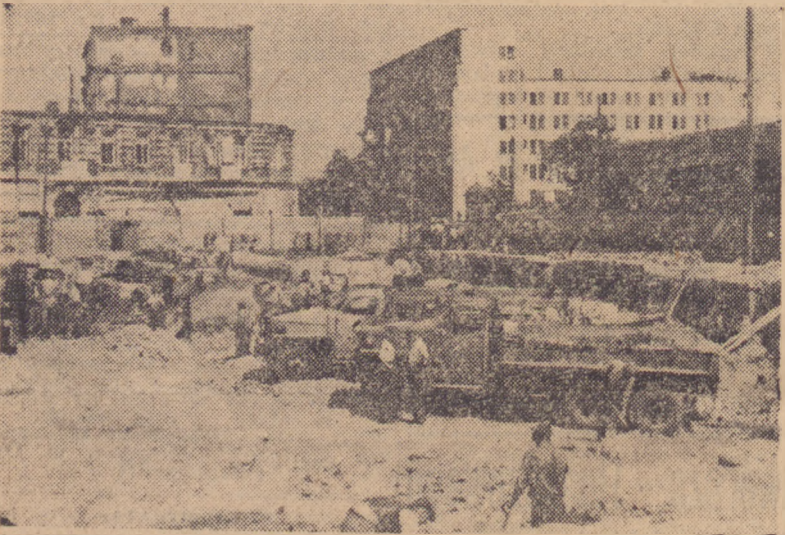
Coraz głębsze są wykopy pod fundamenty wielkiego gmachu Powszechnego Domu Towarowego przy regu Brackiej i Al. Sikorskiego.
