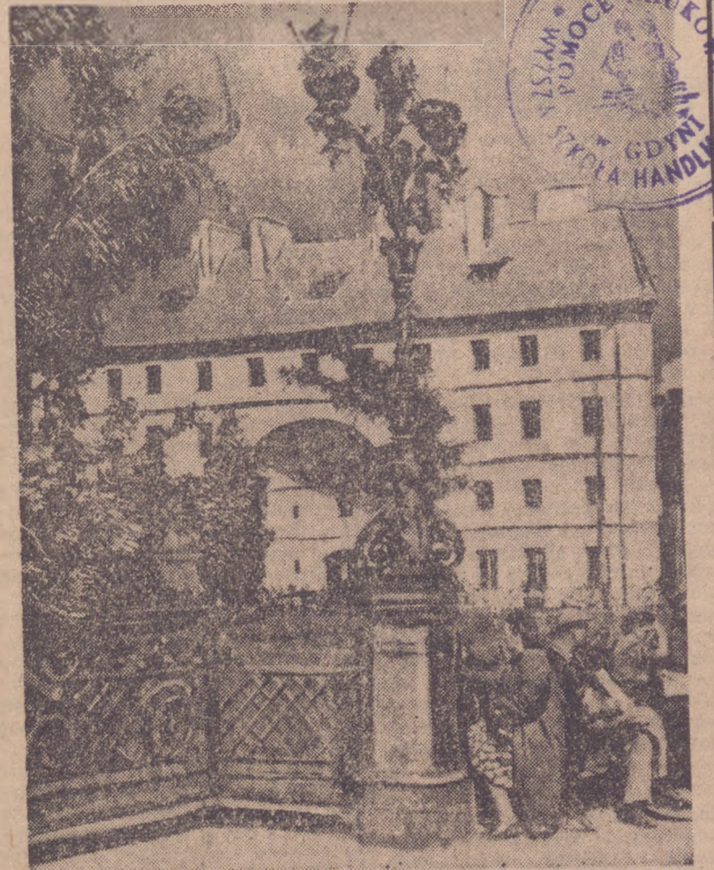
Stary zajazd warszawski na Krak. Przedmieściu, zwany Dziekanką, został już całkowicie odbudowany i umeblowany. Meble są darem Szwajcarii. W budynku tym, w połowie września, zamieszka 120 studentek pochodzących z krakowskiego, Dziekanka bowiem odbudowana została z funduszy Krakowa i służyć ma jako bursa dla studentek. (Fot. API)
