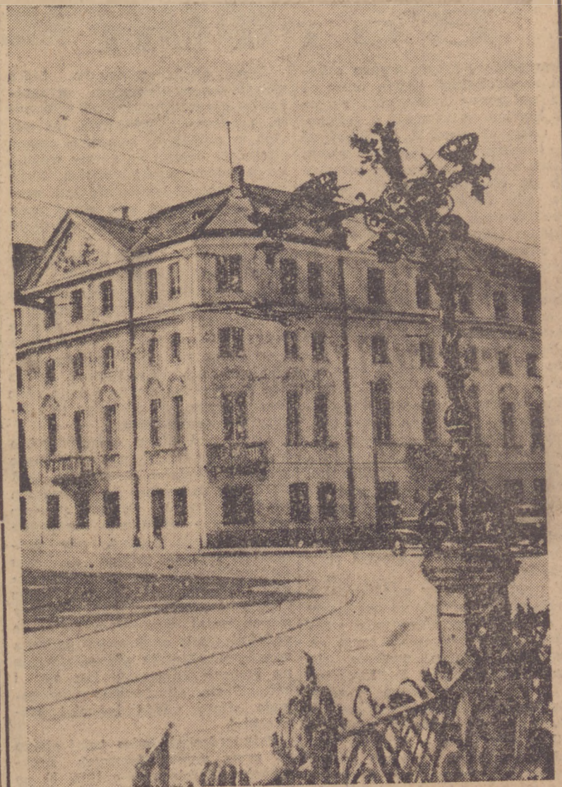
Dawna siedziba Poczty Saskiej na Krak. Przedmieściu róg Trębackiej jest dziś siedzibą Komisji Specjalnej. Dom był spalony i został całkowicie odbudowany w bież. roku. Przy okazji odkryto nowe, piękne szczegóły architektoniczne, skasowano lokale sklepowe i budynki nadano jego pierwotną piękną formę. (Fot. API)
