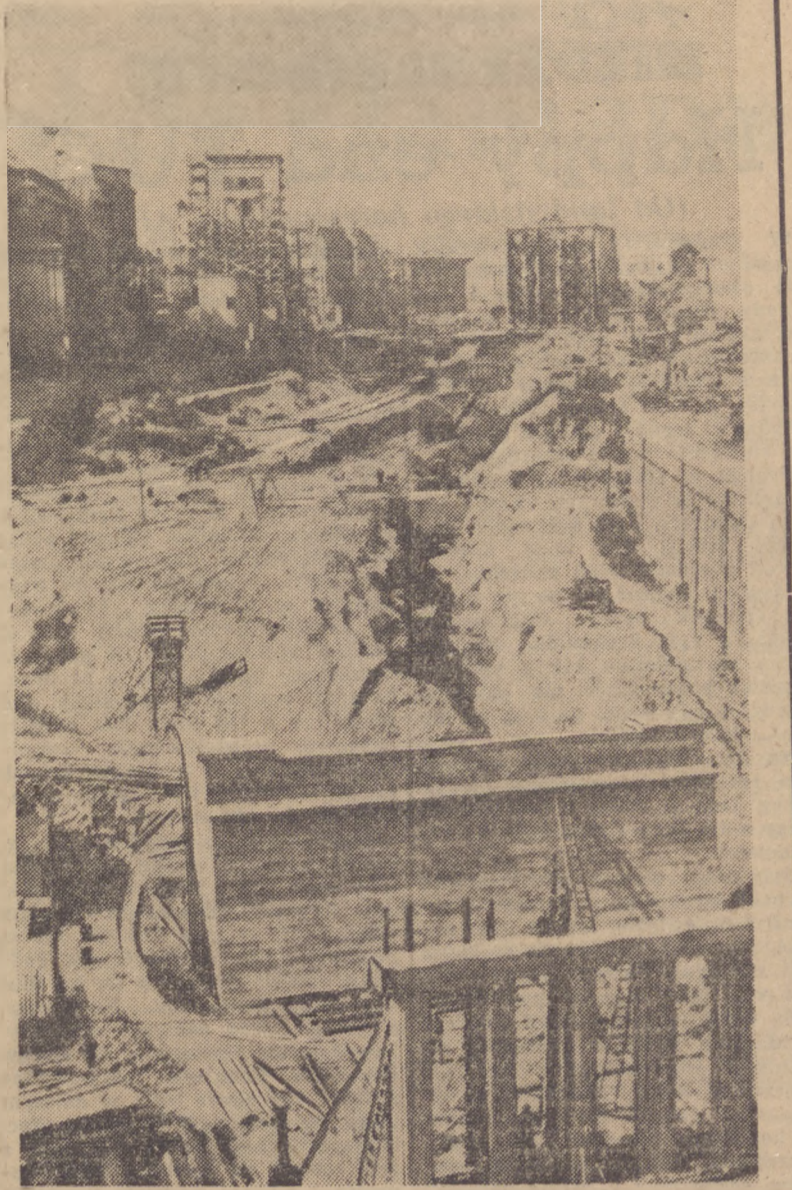
Tak wygląda teren budowy trasy W — Z tuż przy przyszłym moście Śląsko-Dąbrowskim. Na pierwszym planie filar wiaduktu jak nad rynkiem mariensztadzkiem łączy przyczółek mostowy z zachodnią częścią tej arterii komunikacyjnej. (Fot. API)
