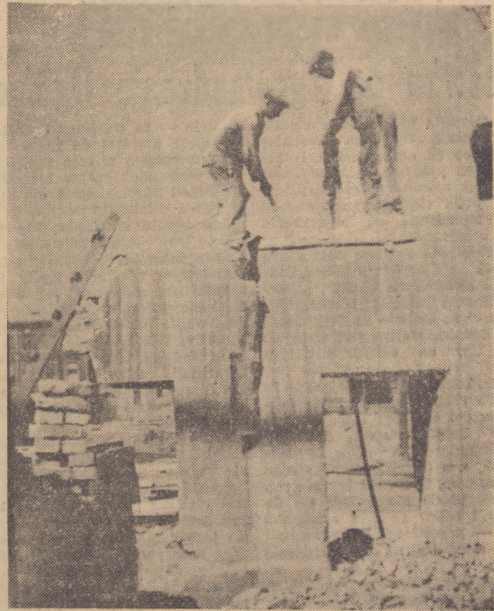
Z terenu budowy Trasy W — Z należało usunąć wszystkie ruiny spalonych kamienic. Betonowe fundamenty i szczątki przedwojennych gmachów trzeba było kruszyć przy pomocy elektrycznych i pneumatycznych pistoletów. Na zdjęciu dwaj robotnicy Faliszewski Zygmunt i Perkowski Jan, specjaliści od kruszenia resztek betonowych murów.
