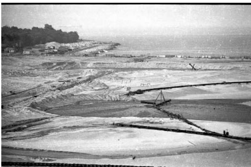
Budowa Portu Północnego w roku 1973, fot. Z. Kosycarz. Więcej zdjęć z budowy na www.kfp.pl
