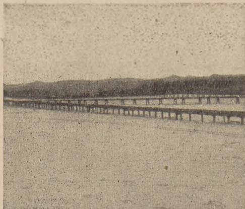
Ryc. 2. System akwaduktów ściekowych rozdzielających ścieki fabryki celulozy na Pustyni Błędowskiej.
