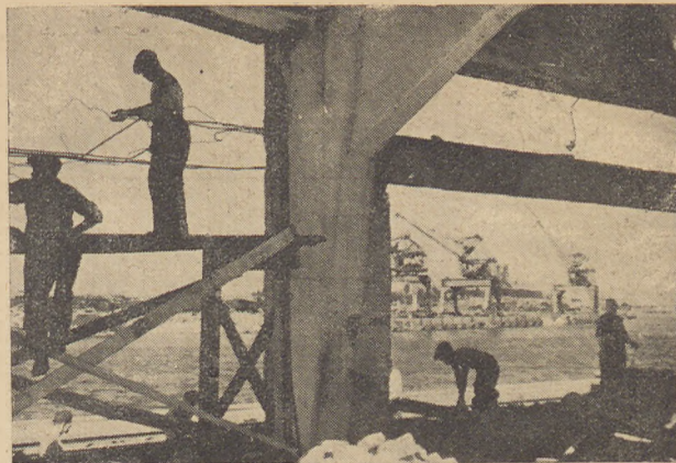
Odbudowa portów posuwa się w tempie.
