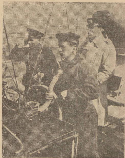
Pomost nawigacyjny skupia wszystkie nici w dowodzeniu okrętem. Dowódca i sternik, połączeni telegrafem maszynowym z motorzystą pracującym pod pokładem, stanowią mózg i nerw trałowca. Zmiana szyku dywizjonu wymaga szczególnej uwagi ze strony dowódcy i sternika. Za chwilę okręt przystąpi do trałowania...
