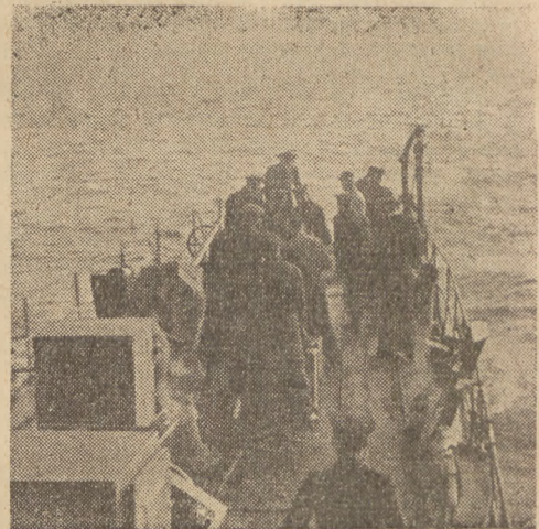
Okręt i załoga gotowe do akcji. Na rufie czynione są ostatnie przygotowania do wypuszczenia trałów. Winda trałowa zaczyna się obracać luzując liny, które siłą marynarskich mięśni zostają zsunięte do wody.
