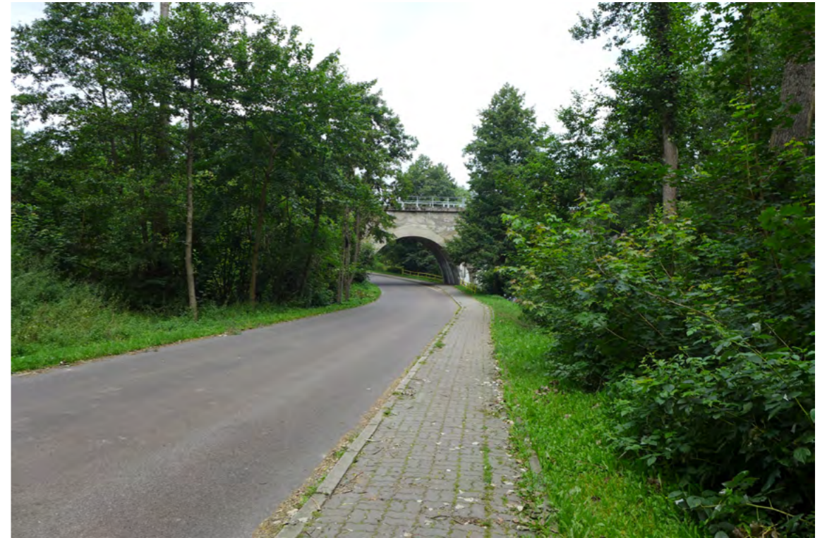
Ryc. 7. Wiadukt kolejowy Fig. 7. Railway flyover
