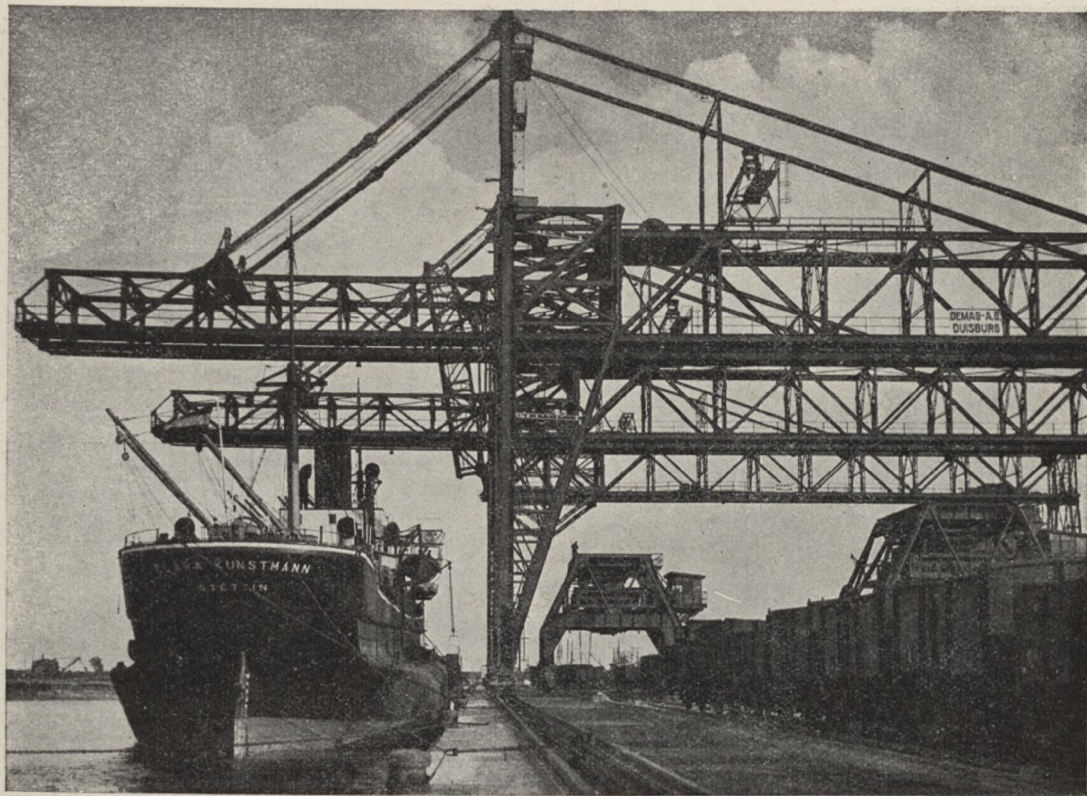
VERLADEBRÜCKEN FÜR ERZE UND PHOSPHATE
