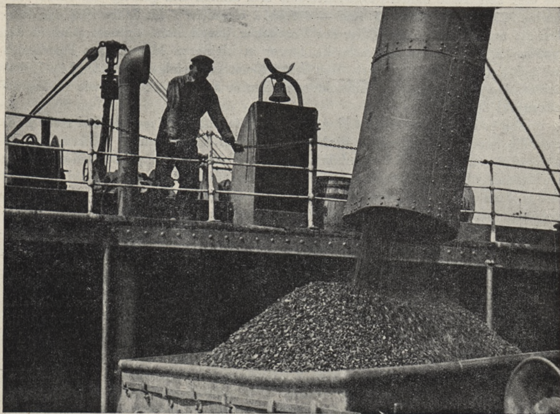
BEENDIGUNG DER ARBEIT DURCH EINE KOHLENVERLADEANLAGE
