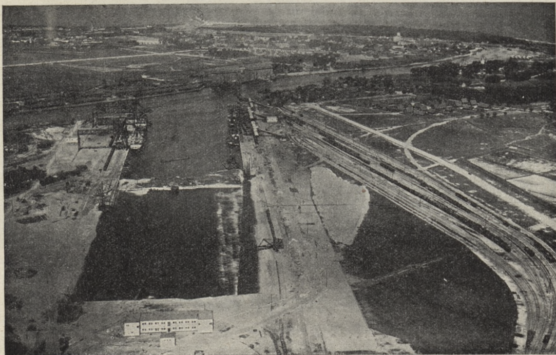
GESAMTANSICHT DES NEUEN MASSENGUTBECKENS
