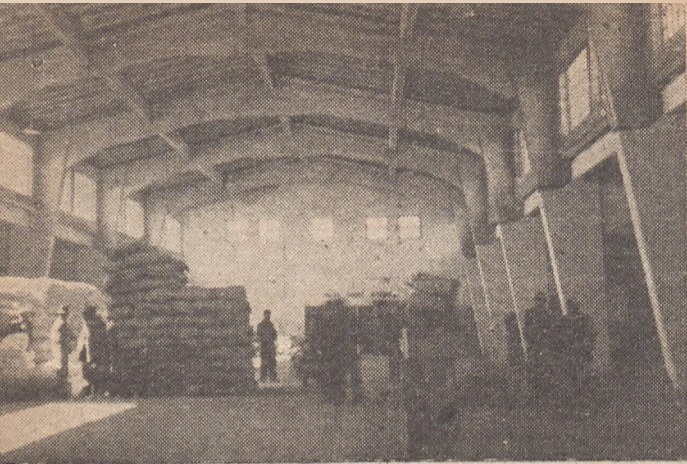
Wnętrze magazynu przejściowego
