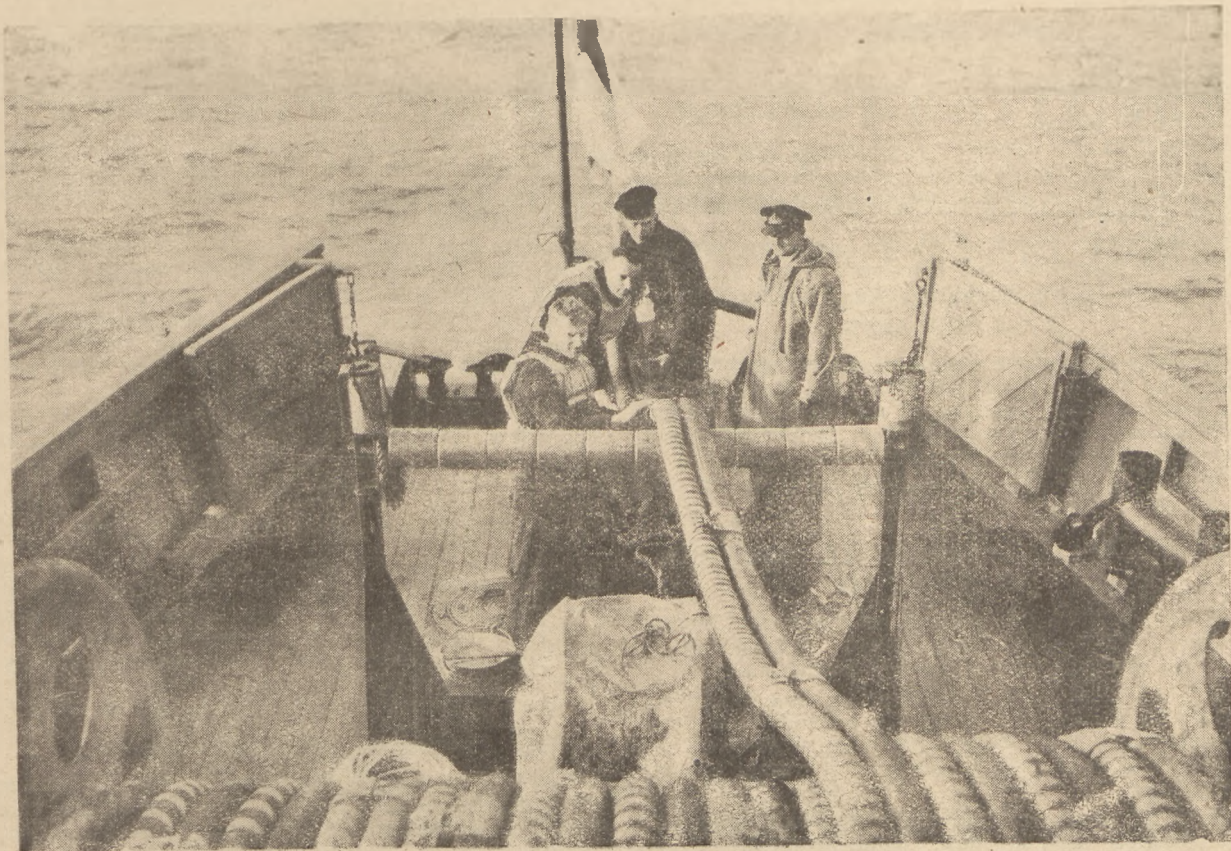
Kładzenie kabla
