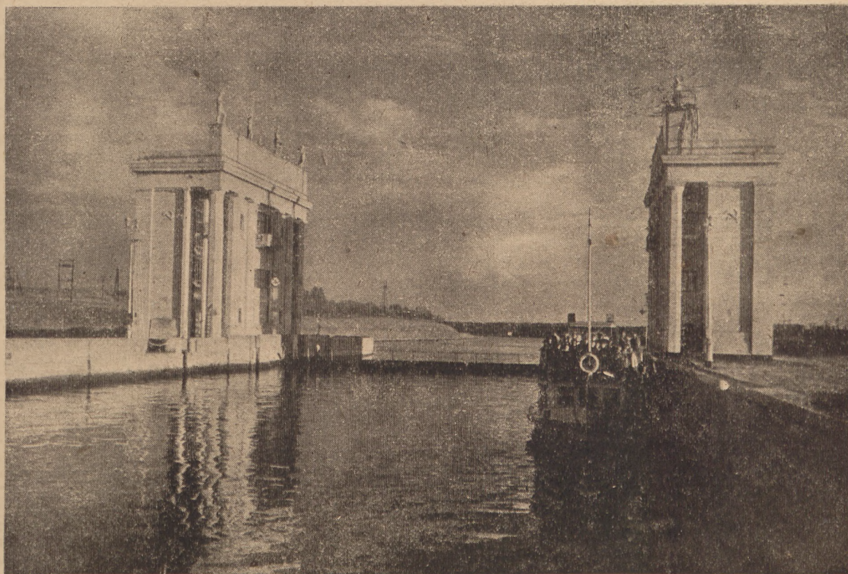
Śluza kanału Moskwa — Wołga, pierwszy próg drabiny systemu dróg wodnych w kierunku Wołgi.
