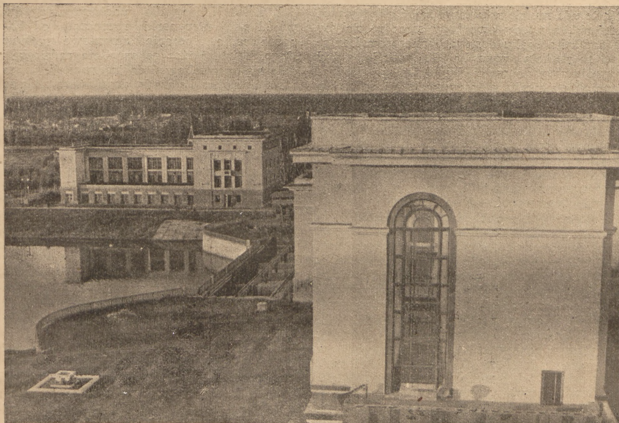
Miasto stołeczne Związku Radzieckiego, Moskwa, stało się „portem pięciu Mórz“, dzięki rozbudowie systemów wodnych. Na zdjęciu widzimy zapórę wodną kanału Moskwa — Wołga, zbudowaną według najnowszych zasad techniki.
