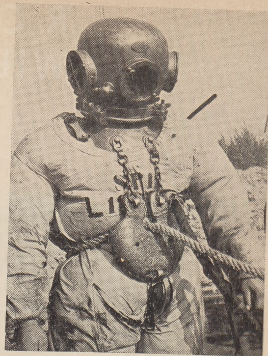
Pracownicy specjalnej ekipy P. P. R. C. I. P., zatrudnieni przy poszerzaniu zniszczonego podczas wojny wejścia do portu gdyńskiego zadokumentowali swą wolę walki o pokój przedterminowym wykonaniem powierzonych prac, w czym szczególnie przodowali nurkowie.
