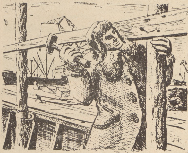
...dwóch marynarzy nosi słupy, zakłada je w kłamy, jeden przybija deski wzdłużne...
