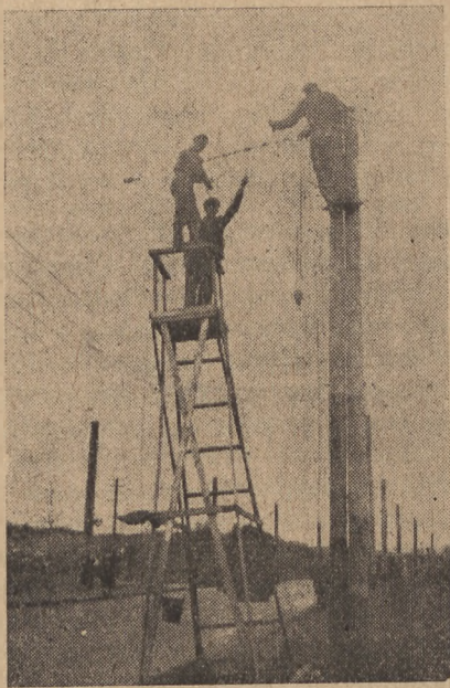
Fragment odbudowy linii trolleybusowej na Chylonic
