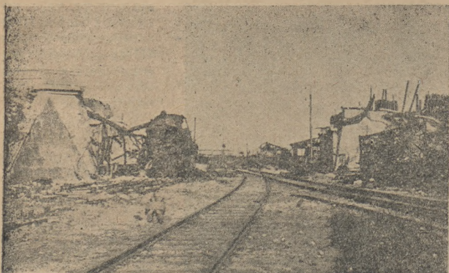
Gdynia. Zburzony wiadukt Nr. 1.
