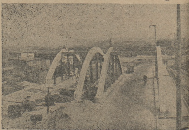
Gdynia. Odbudowany wiadukt Nr. 1.
