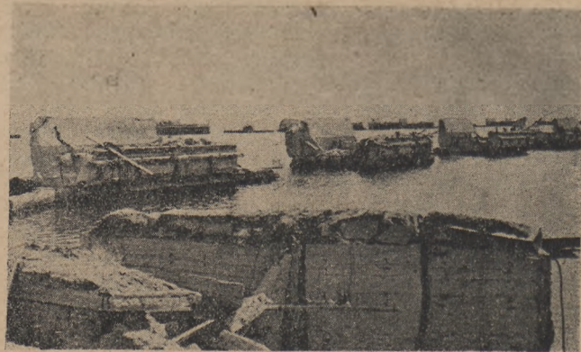
Gdynia. Zniszczone falochrony.
