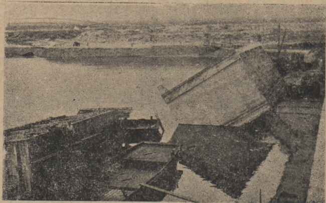
Gdynia. Spuszczanie na wodę skrzyń falochronowych.
