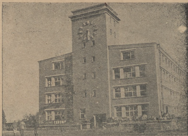
Szczecin. Magazyn Nr. 7 na Gryfii.
