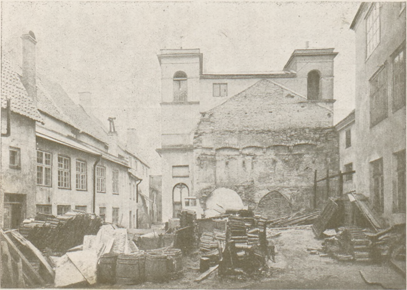
Abb. 35. Alte Dormitoriumswand, als Aussenmauer der St. Peter- und Paulskirche ausgenutzt.
