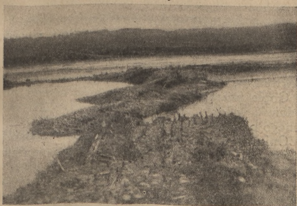
Rys. 4. Tama poprzeczna z koronką faszynową po przejściu lodów i wody wiosennej (rz. Dunajec).
