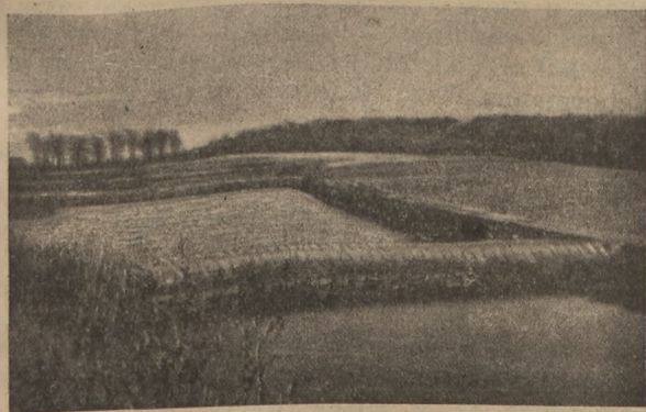
Rys. 5. Tama podłużna z poprzeczkami w końcowej fazie remontu z okładziną betonową.
