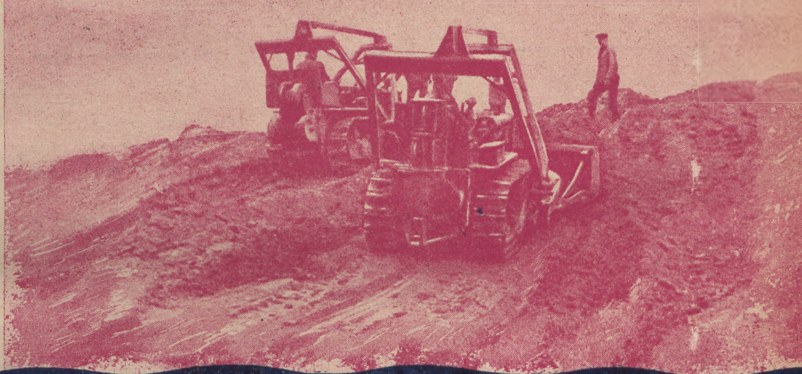
BUDOWA WAŁÓW NAD WISŁĄ
