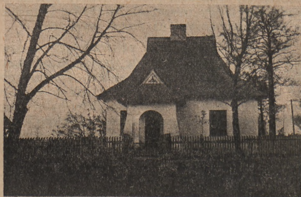
Rys. 3. Strażnica przy upuście Suchorzeczka (odbudowa 1946 r.).
