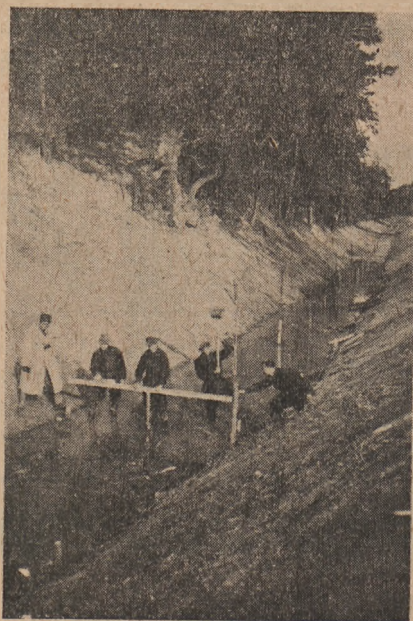
Rys. 1. 17 Brygada SP przy robotach ziemnych na „kanale ulgi” w Bielinku.
