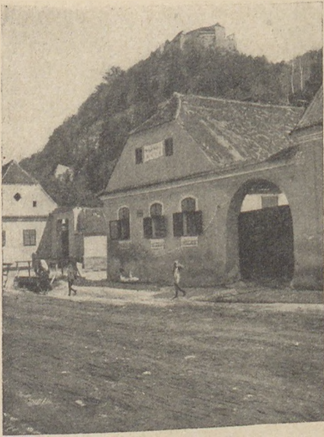
Abb. 6. Bauernhaus aus Rosenau mit Nebenstube und dem hohen überwölbten Einfahrtstor, im Hintergrund die alte Bauernburg.
