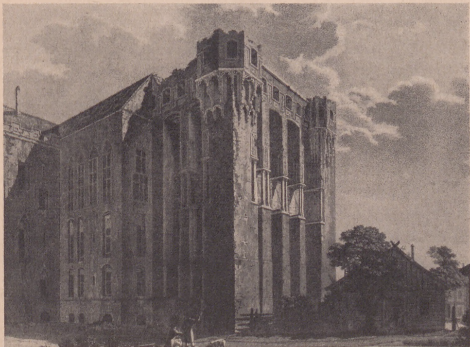
Die Fassade des Kapitelsaales der Marienburg
