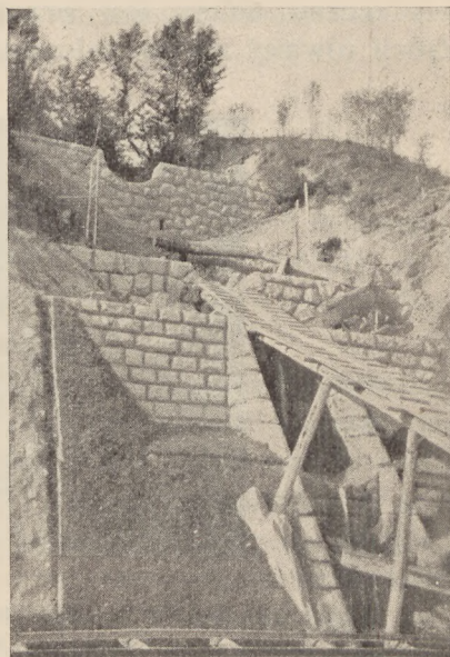
Fot. 3. Budowa tamy na niewielkim strumieniu górskim. Kosztowna budowa w porównaniu do niskich koryżyści — zatrzymania kilku lub kilkudziesięciu metrów sześcienn. kamieni
