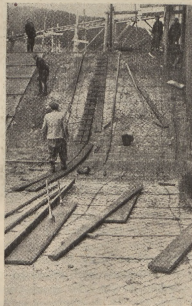
Rys. 13. Siatka żelazna ułożona na warstwie wyrównawczej na płycie jazu (październik 1946 r.).
