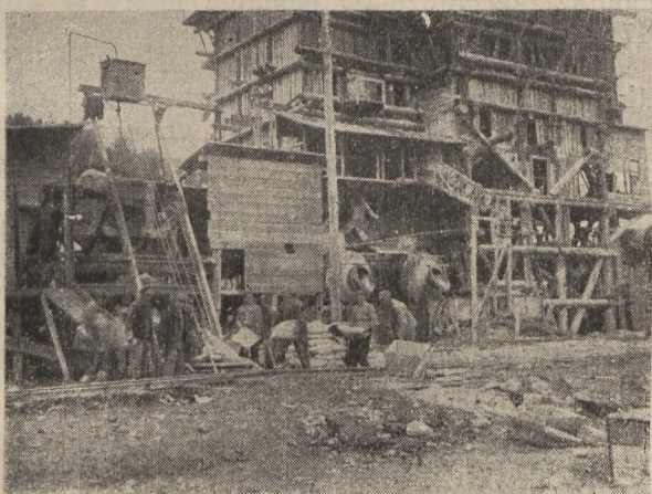
Rys. 12. Betoniarka (750 l) na tle rozmontowanej przez okupanta fabryki betonu (październik 1946 r.).
