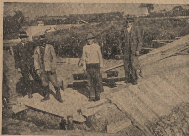
Rys. 3. Budowa progu żelbetowego na potoku Wapiennickim.
