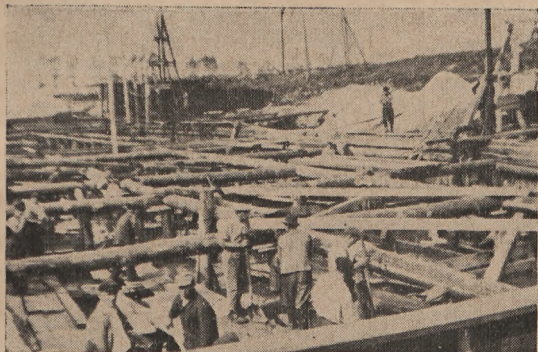
Rys. 14. Śluza „Koszewo”. Wykop dołu fundamentowego prowadzono w ok. 80% czerpaniem.
