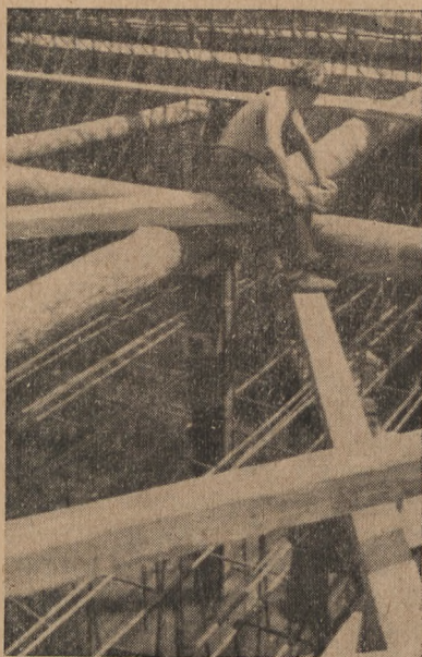
Rys. 21. Zbrojenie płyty i ścian śluzy „Koszewo”.
