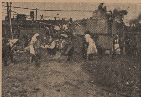
Rys. 24. Śluza „Koszewo”. Kobiety również pracują przy betonowaniu, nie ustępując mężczyznom.
