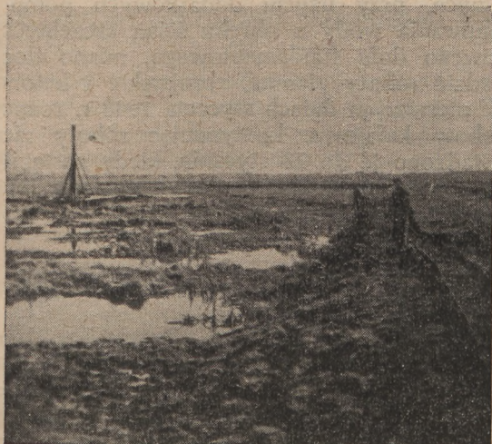
Rys. 7. Tu będziemy budowali śluzę „Koszewo”.
