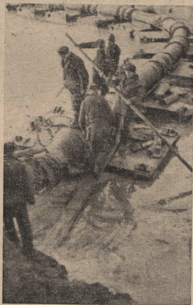
Rys. 8. Łączenie rurociągu tłoczego pływającego ze stałym.
