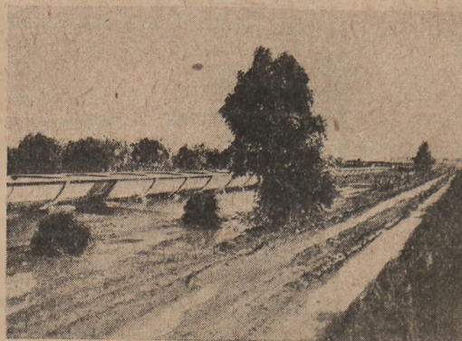
Rys. 5. Kanał żelbetowy przed obsypaniem ziemią.
