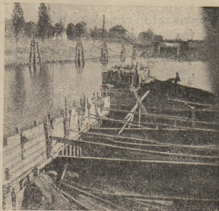
Rys. 3. Szczegół nadbudowy burt barki.
