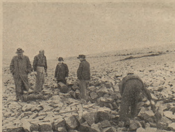
Rys. 5 Remont okładziny na skarpie zapory w Otmuchowie.
