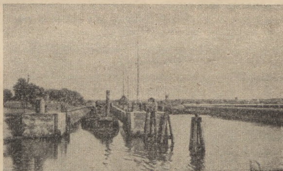
Rys. 3. Śluza Ujście Nysy na Odrze.
