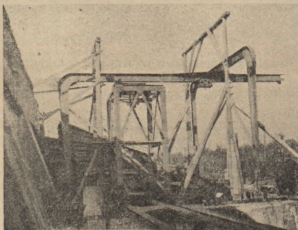
Rys. 3. Remont dźwigu w Otmuchowie.
