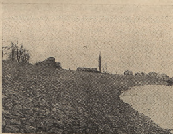
Rys. 6. Wybudowany wał ochronny zbiornika w Turawie przy wsi Antoniów.
