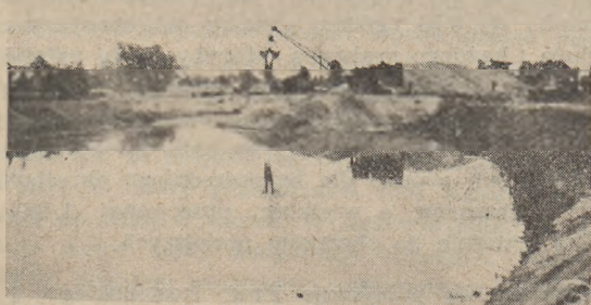
Rys. 1. Budowa kanału lateralnego wzdłuż Przemszy (koło m. Jażdże).
