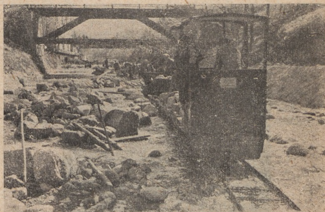
Rys. 8. .... trudności przy usuwaniu uszkodzeń zabudowy potoku ....
