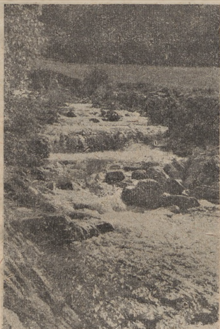
Rys. 5. .... stopnie uprzednio podmyte zostały zerwane..
