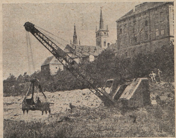
Rys. 3. Bagrowanie stawu-zbiornika.
