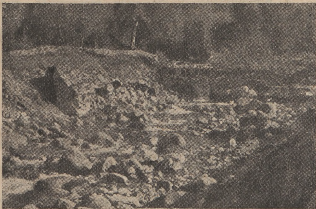
Rys. 12. .... szczątki zabudowy Małej Łomnicy....
