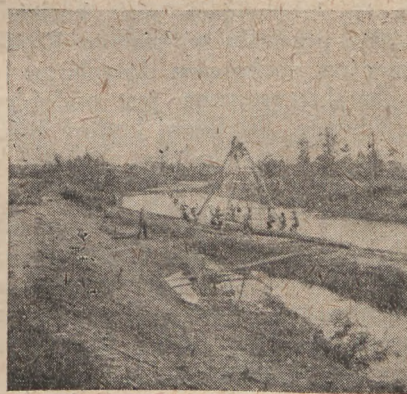
Rys. 4. Bicie ścianki palisadowej dla progu w km 28 rz. Olzy.
