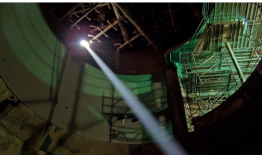
Montaż instalacji ochrony protektorowej wieży wydobywczej (górną fotografią) Absorber instalacji odsiarczania spalin (dolną fotografią)
