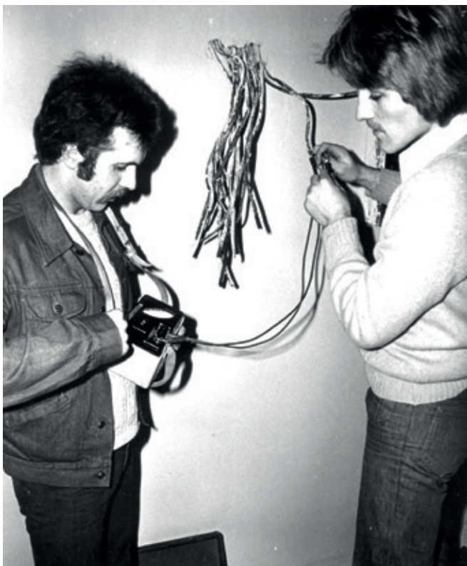
Pomiary elektryczne w SSP „Techno-Service”
