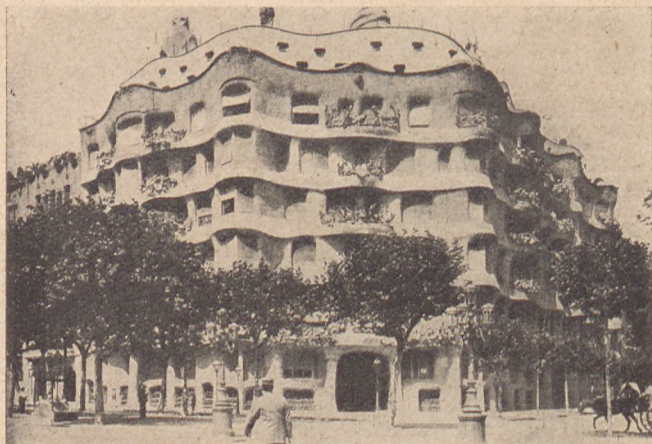
Dom o falistej linii fasad, przykład modernizmu w architekturze Barcelony.
