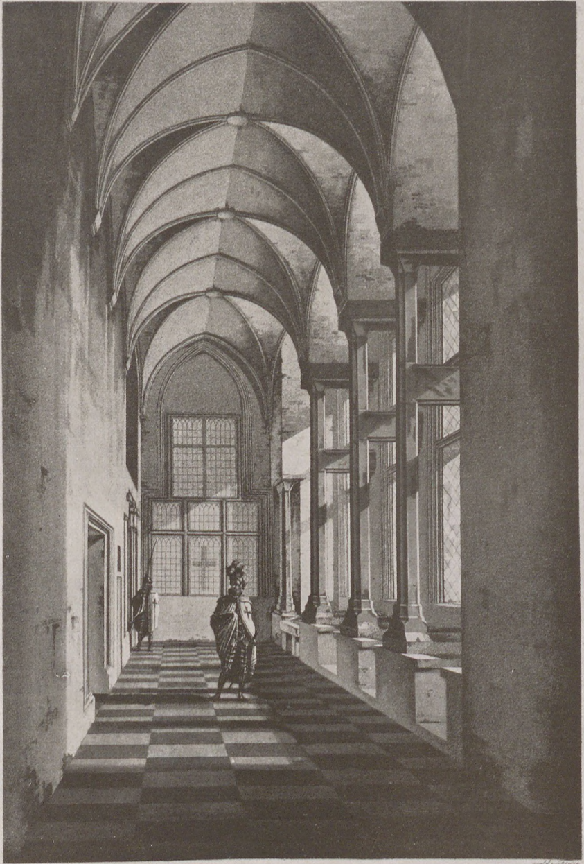
Korridor vor dem Kapitel-Saal
