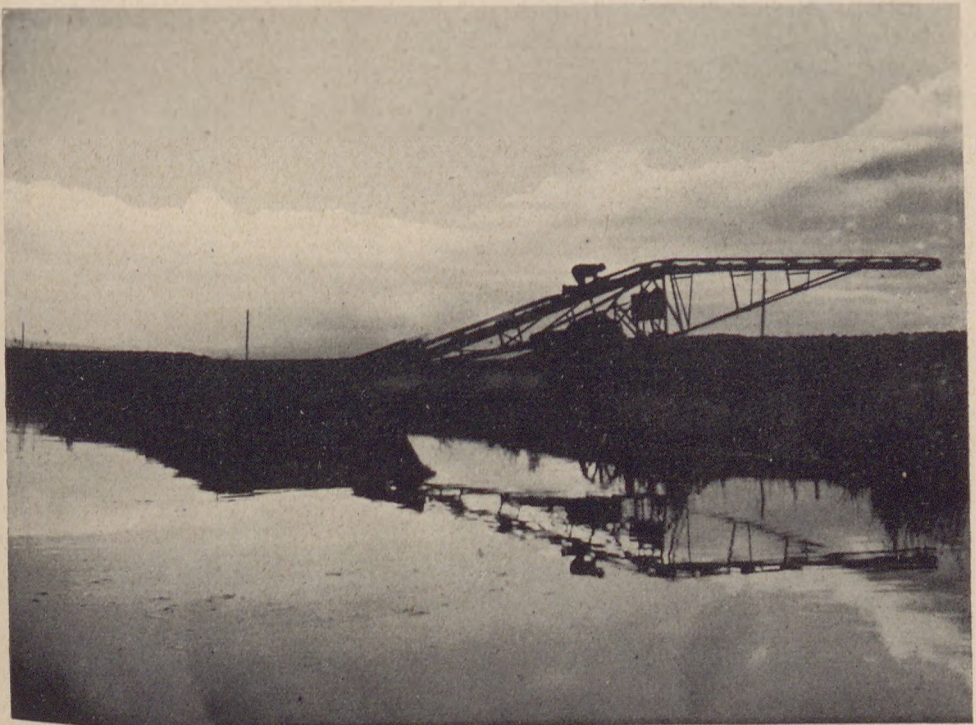
Weit über die blinkenden Wasser kündigt die einsame Silhouette des Förderbandes am Feierabend von der erfüllten Arbeit
