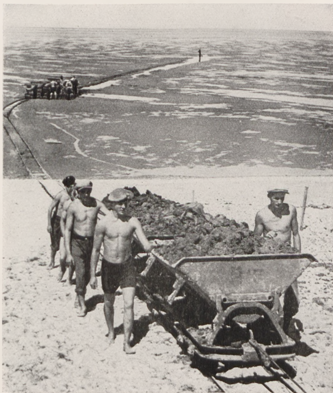
Deichbauten in Schleswig
