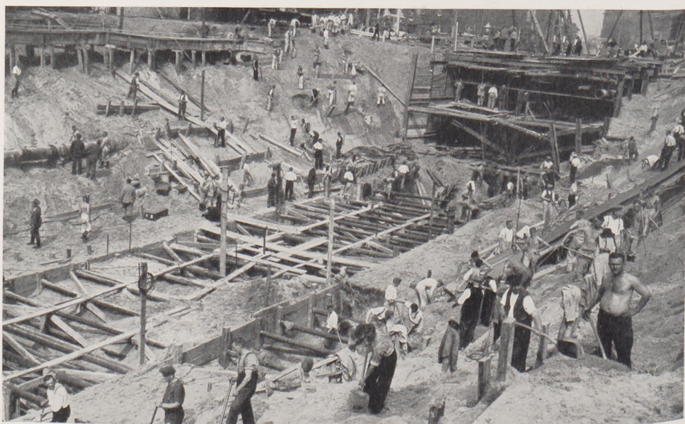
Das Einsturzungsglück beim Bau der Nord-Südbahn in Berlin (19. 8. 1935)
