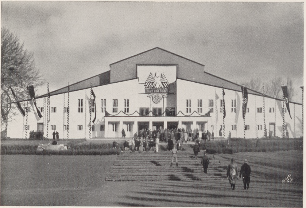
Die neue Kongresshalle in Goslar
