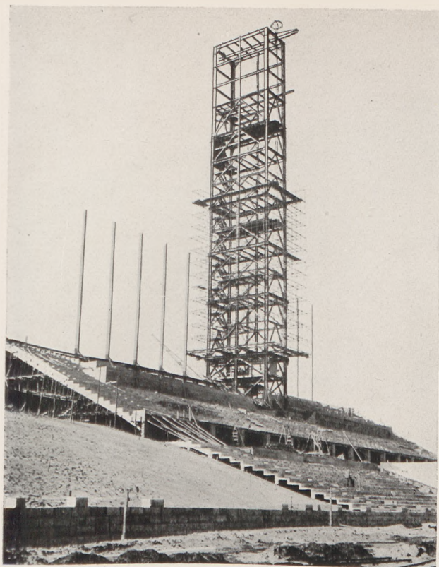
Der Führerturm auf dem Reichsportfeld im Bau
