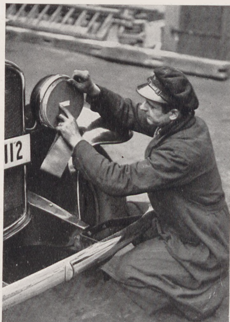
Die Scheinwerfer der Autos werden, bis auf einen kleinen Spalt, zugeklebt
