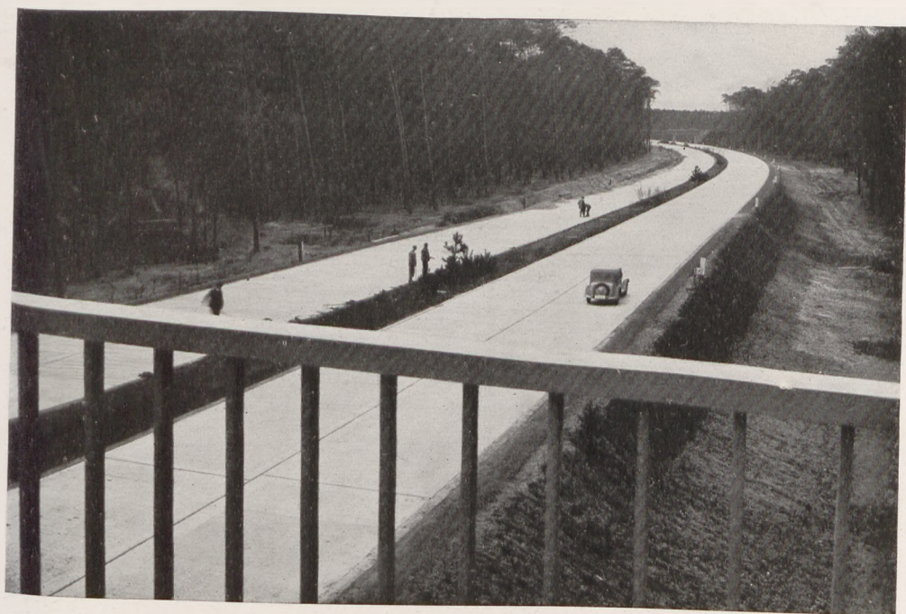
Blick auf die fertige Autobahn
