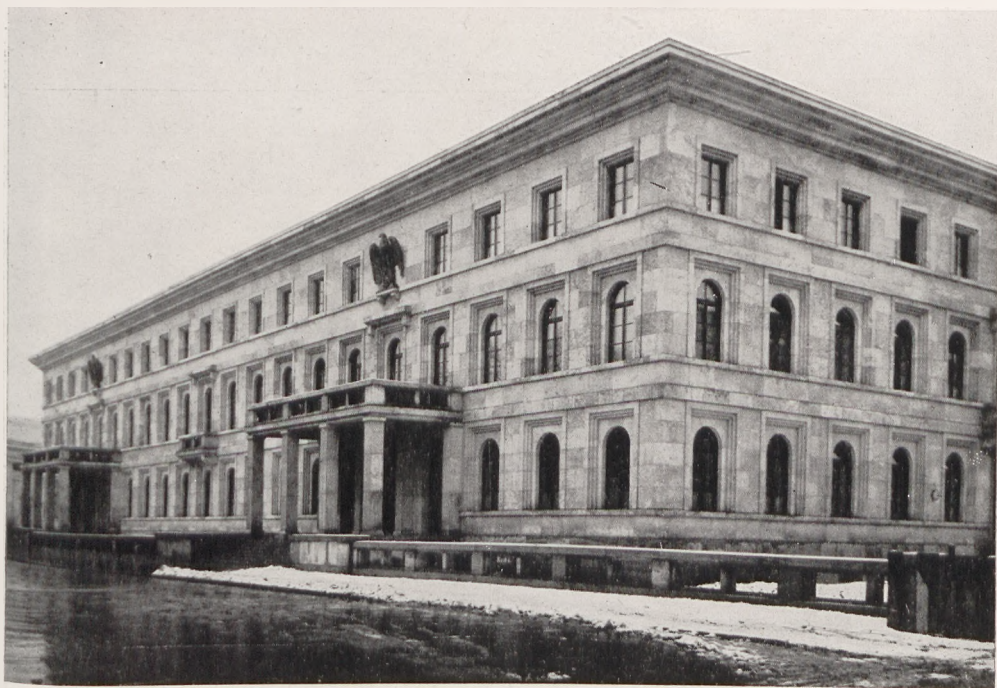
Der Neubau des Verwaltungsgebäudes der NSDAP. (Einweihung am 11. 2. 1937)
