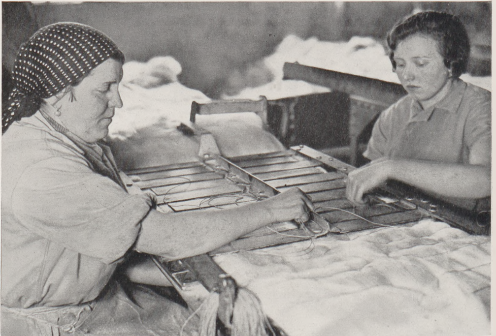
Herstellung einer Isoliermatte aus Glasstoff
