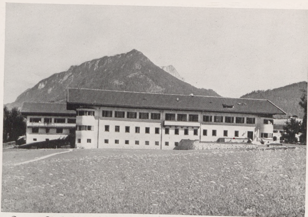
Das neue Dienstgebäude der Reichskanzlei auf dem Obersalzberg (Nichtfest 18. 1. 1937)
