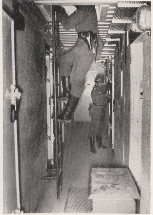
Inneres eines Verteidigungswerkes Der Westwall
