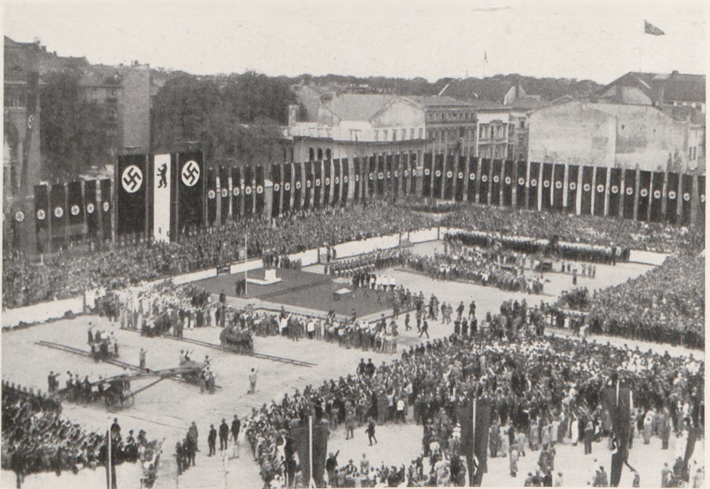
— arbeitet das deutsche Volk und baut auf: Grundsteinlegung zum „Hause des Deutschen Fremdenverkehrs“ durch den Führer (14. 6. 1938) — Arbeitsbeginn an 16 Berliner Großbaustellen
