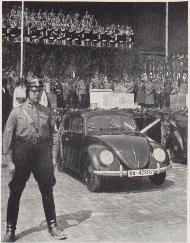
Grundsteinlegung zum Volkswagenwerk bei Gallersleben durch den Führer (26. 5. 1938)
