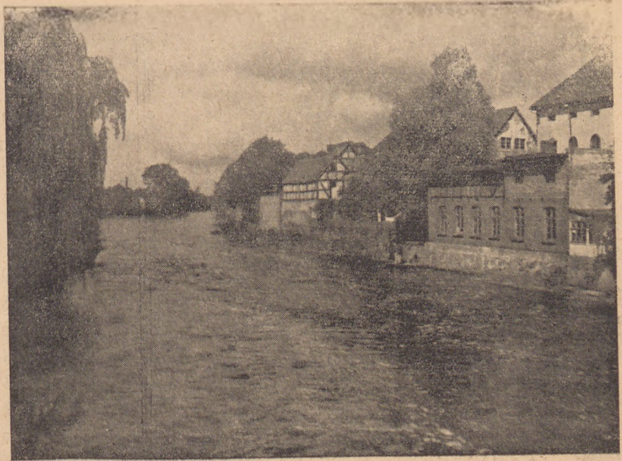
Darłowo — budowle ciągną się ponad rzeką Wieprz w kierunku portu.
