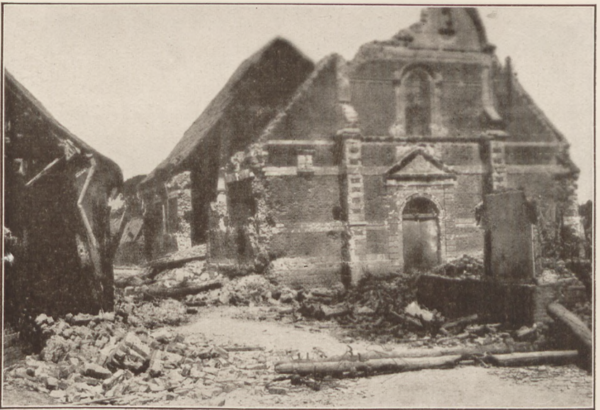
Comblès, Umgebung der Kirche nach schwerer Beschädigung.
