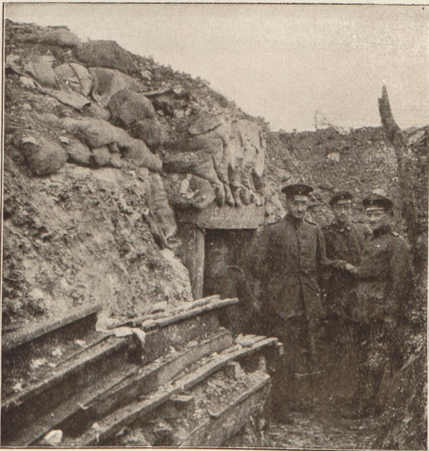
Notdürftig ausgebesserter Stolleneingang im zertrommelten Graben.
