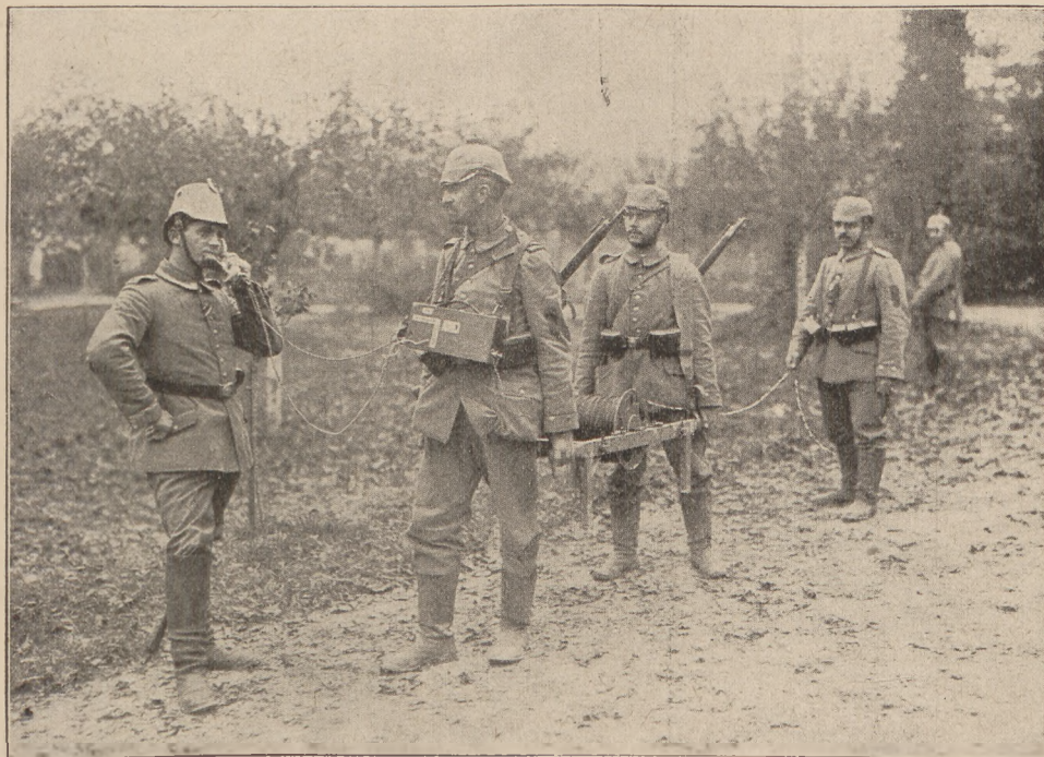
Legen und Prüfen einer Telephonleitung im Felde.
