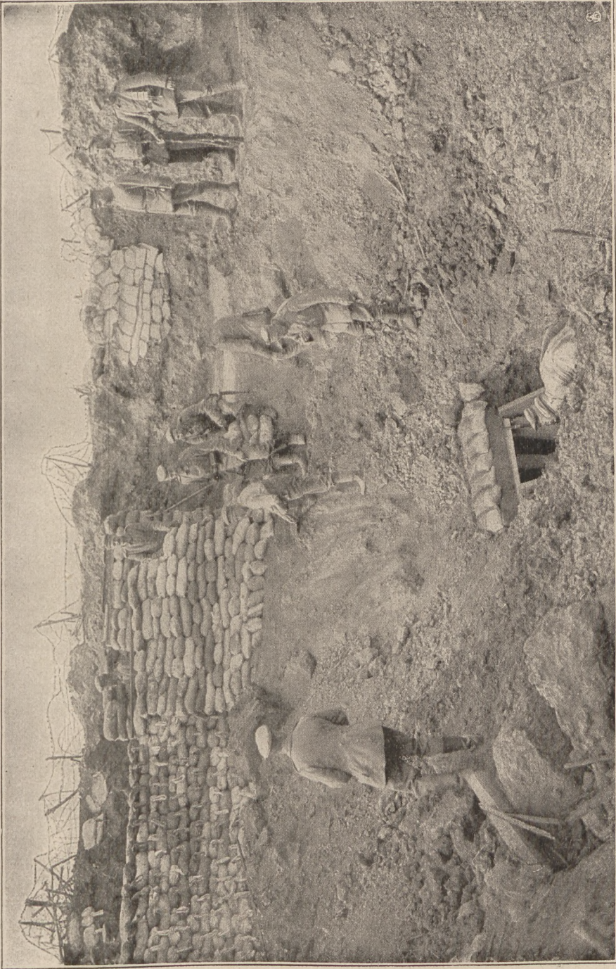
Wiedereraubau eines gesprengten französischen Schiffsengrabens.
