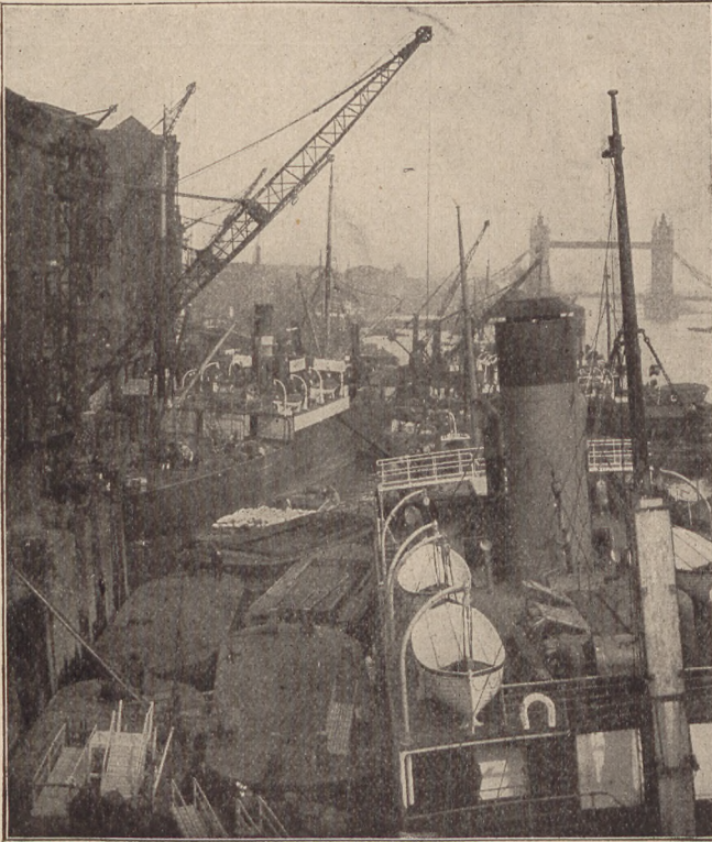
Ankerplatz an der Themse bei London mit der Towerbrücke im Hintergrund.
