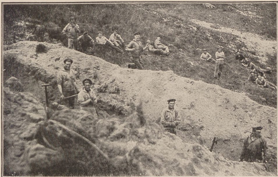
Deutsche Marineinfanterie beim Bau von Unterständen an der flandrischen Küste.
