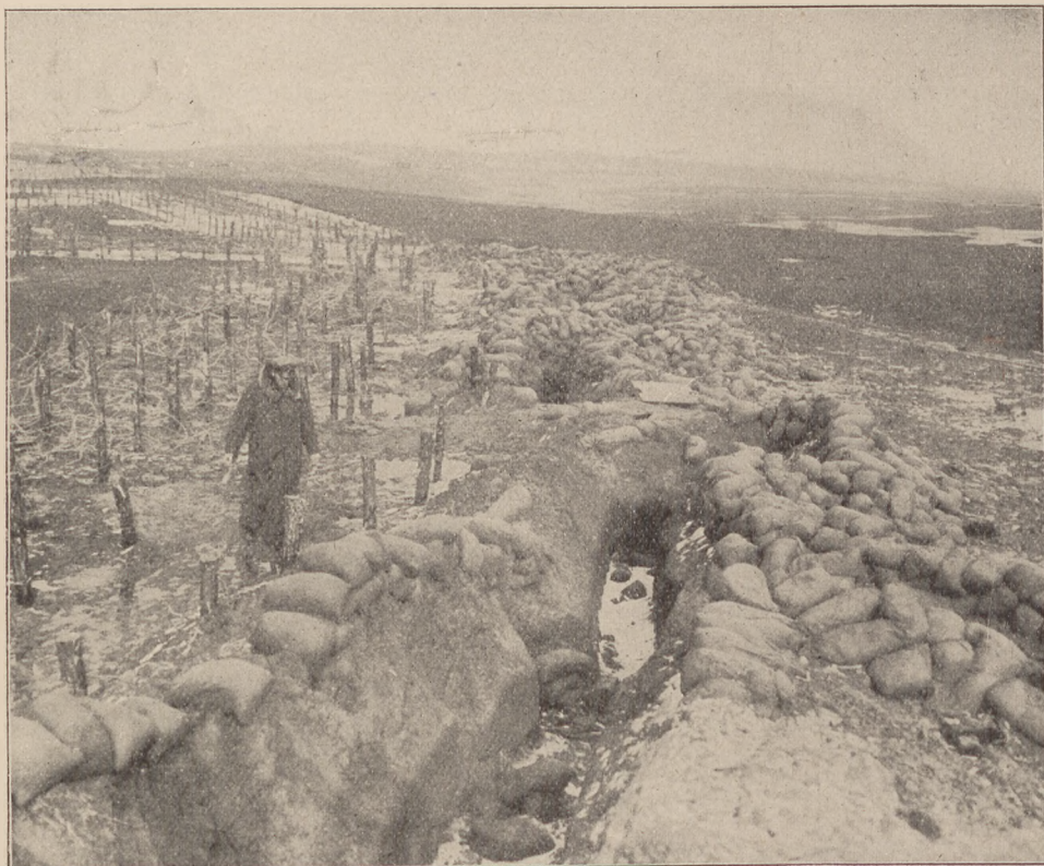
Erstürmte, mit Sandsäcken befestigte russische Schützengräben mit davorliegendem Drahtverbau.
