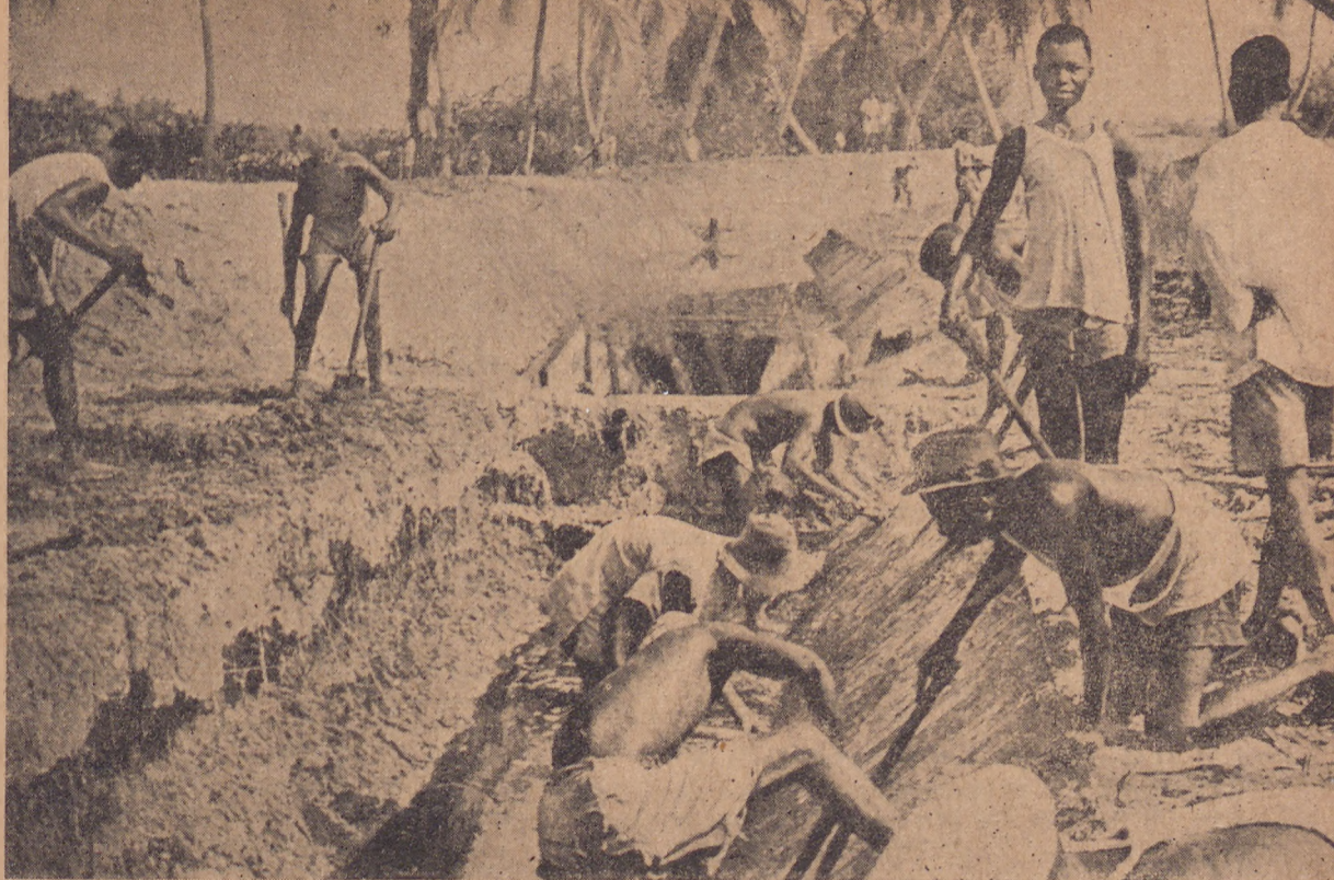
Najskuteczniejszym sposobem przeciw malarii było dotychczas osuszanie błot. Ta ilustracja pokazuje drenowanie błotnistych obszarów w Lagos (Brytyjska Afryka Zachodnia).
