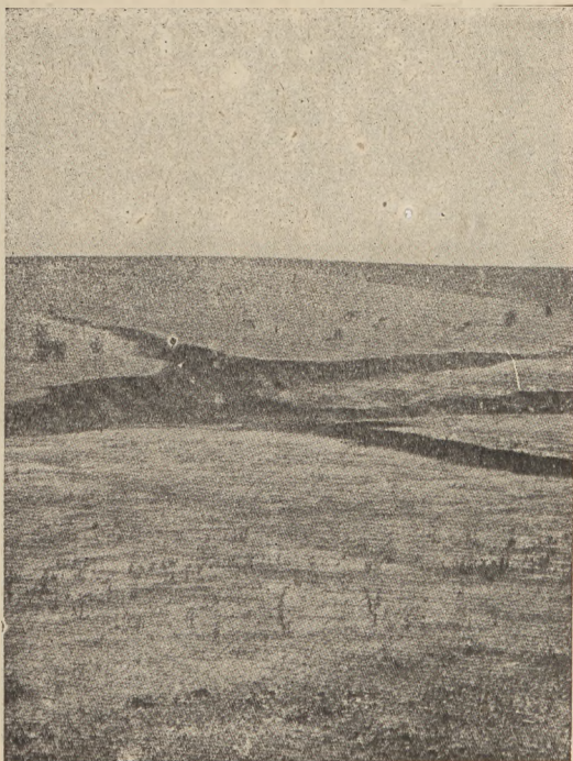
Pastwisko zrujnowane przez erozję
