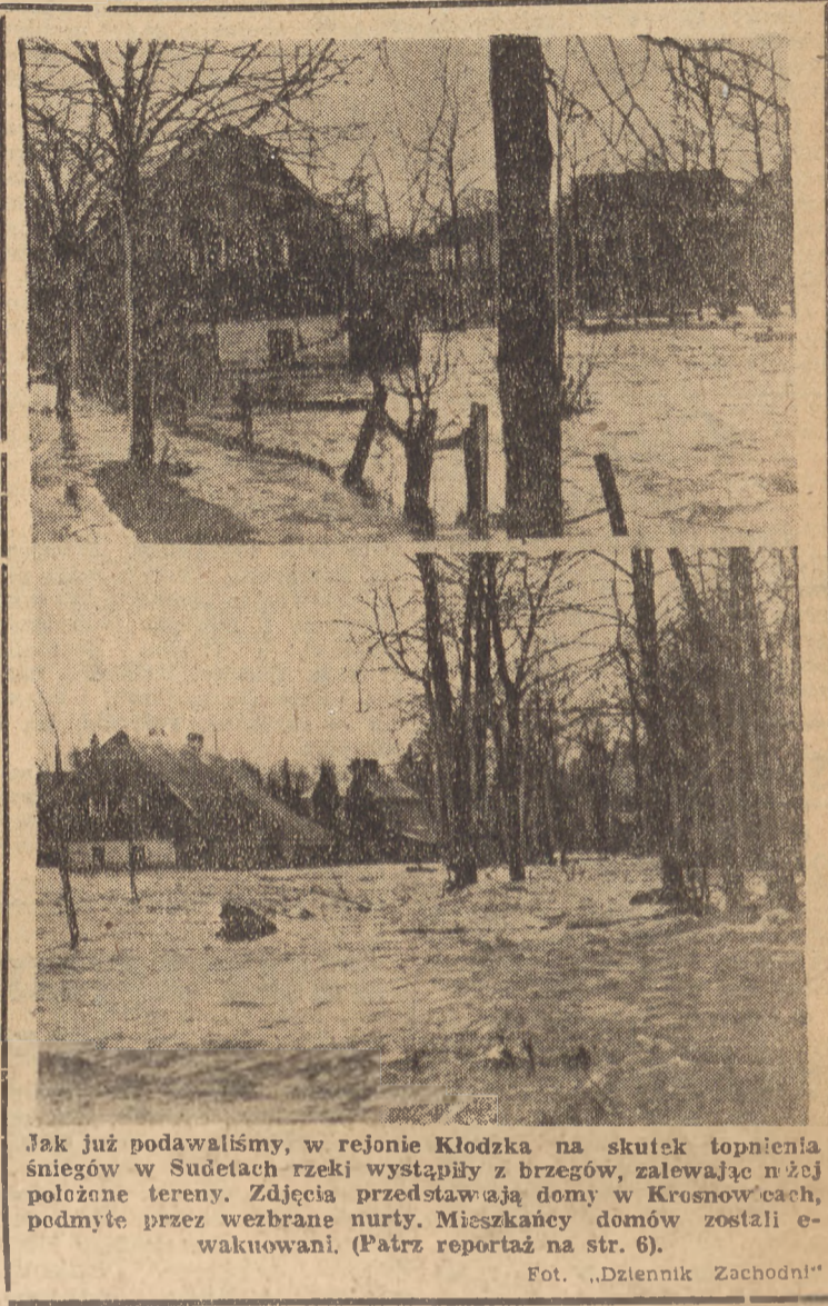
Jak już podawaliśmy, w rejonie Kłodzka na skutek topnienia śniegów w Sudetach rzeki wystąpiły z brzegów, zalewając niżej położone tereny. Zdjęcia przedstawiają domy w Krosnowicach, podmyte przez wezbrane nury. Mieszkańcy domów zostali ewakuowani. (Patrz reportaż na str. 6).
