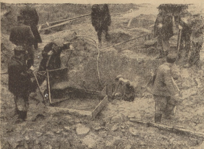
Wre praca przy zakładaniu betonowych słupów, na których wesprze się fundament olbrzymiego, podziemnego garażu. 81 tych słupów wykonuje załoga robocza Wspólnego Domu jako dodatkową pracę, dla uczczenia Kongresu Zjednoczeniowego
