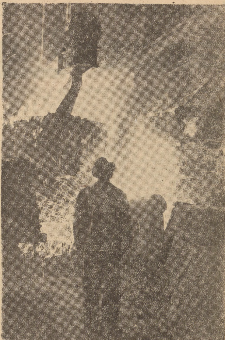
Wielka kadź napelniona już jest płynną stalą. Resztki żużlu spływają z pieca martenowskiego
